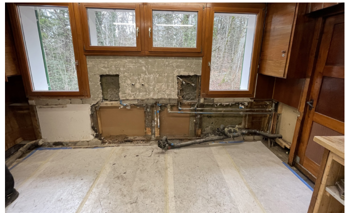
Aus der Baustelle: die Küche ist ausgehöhlt
